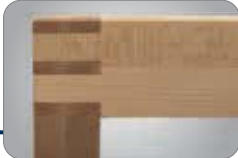
Fingerverzinkung in Hinterzange und Beiladerücken
